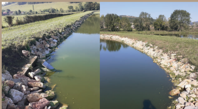
Enrochements sur le bassin de lagune, après remontée du niveau d'eau
